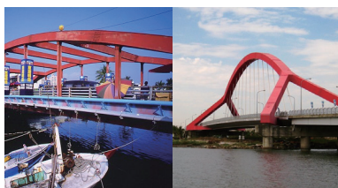
豐漁橋、進德大橋
