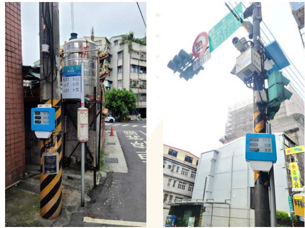
▲新式智慧型站牌可附掛各式既有桿件 - 電桿
