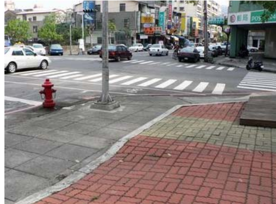
圖 2.1.18 自行車道與道路接鄰處之斜坡設計
