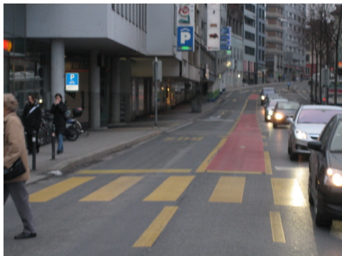
圖 2.2.20 車道配置由外而內分別為公車專用道、自行車道及一般車道 資料來源:本計畫實地拍攝(2007年1月,瑞士盧森市)
