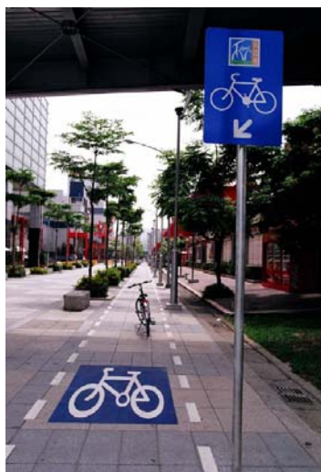
圖 2.1.9 人行道人車分離設置 圖 2.1.10 人行道人車共用設置 圖 2.1.11 通過路口之連續車道標線
