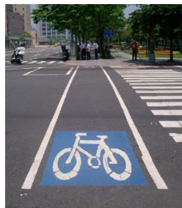
圖 2.1.9 人行道人車分離設置 圖 2.1.10 人行道人車共用設置 圖 2.1.11 通過路口之連續車道標線
