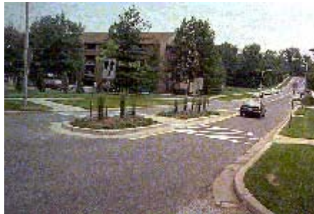
圖 2.2.26 藉中央分隔島縮減車道寬度
