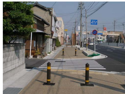
圖 2.2.6 人行道出入口 設置阻攔杆
