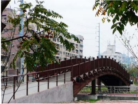
圖 2.1.17 自行車專用天橋，下方為車道
