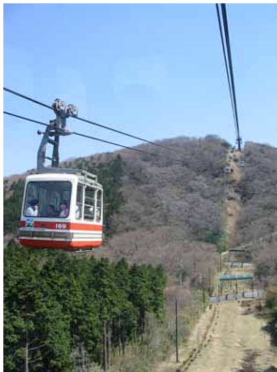
圖 8-2 早期纜車線線下為維修道
