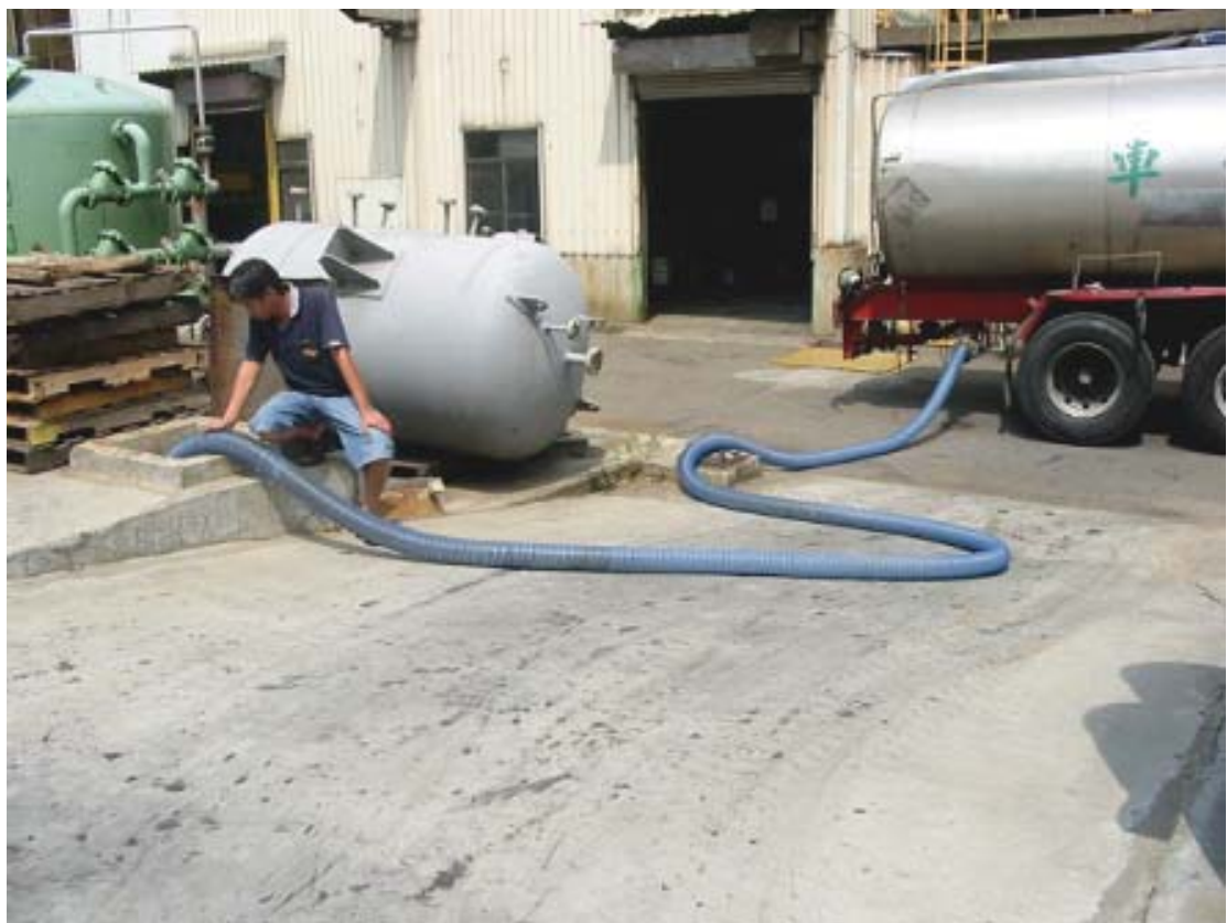
照片 4.4-5 再生水試用實廠送水情形(長春樹脂公司)
