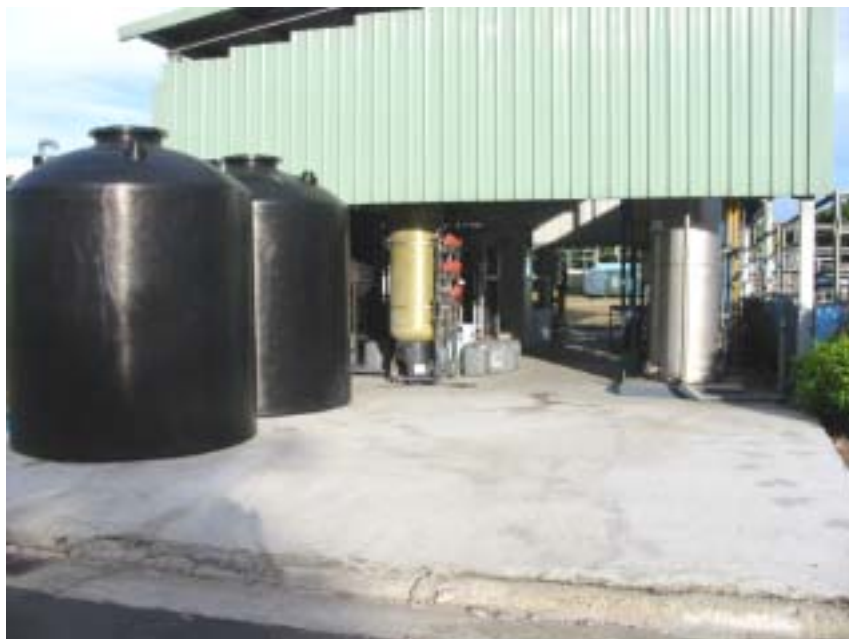
照片 4.4-2 再生水試用儲水桶及抽水設施架設-2
