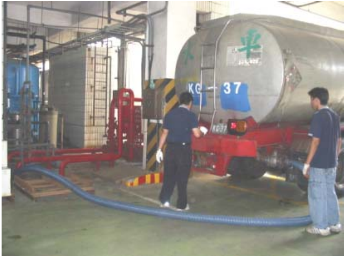
照片 4.4-4 再生水試用實廠送水情形(晶強電子公司)
