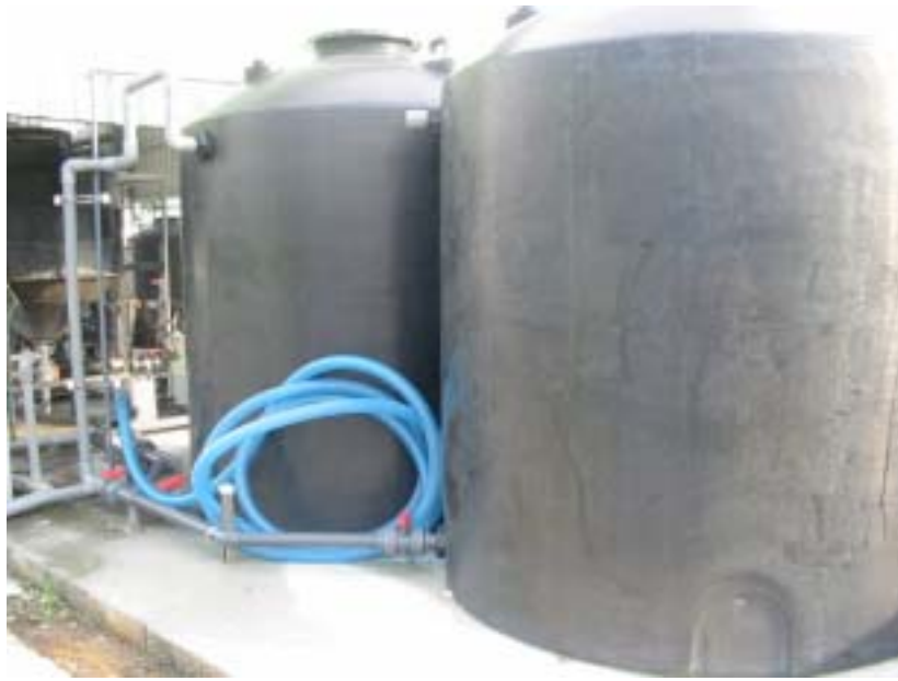
照片 4.4-1 再生水試用儲水桶及抽水設施架設-1
