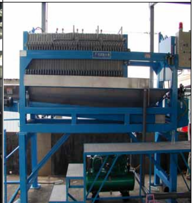
照片 4、設備安裝（板框式污泥機）
