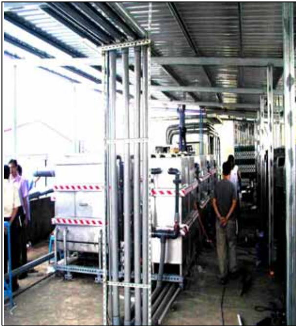
照片 1、設備安裝（電凝設備）
