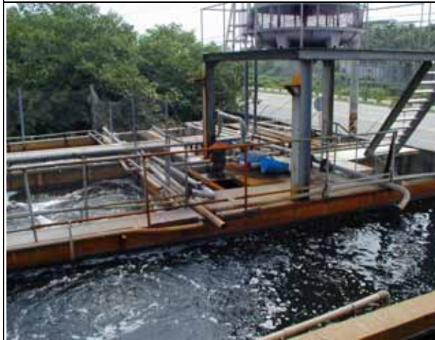
照片三、高濃度廢水處理廠（曝氣池）
