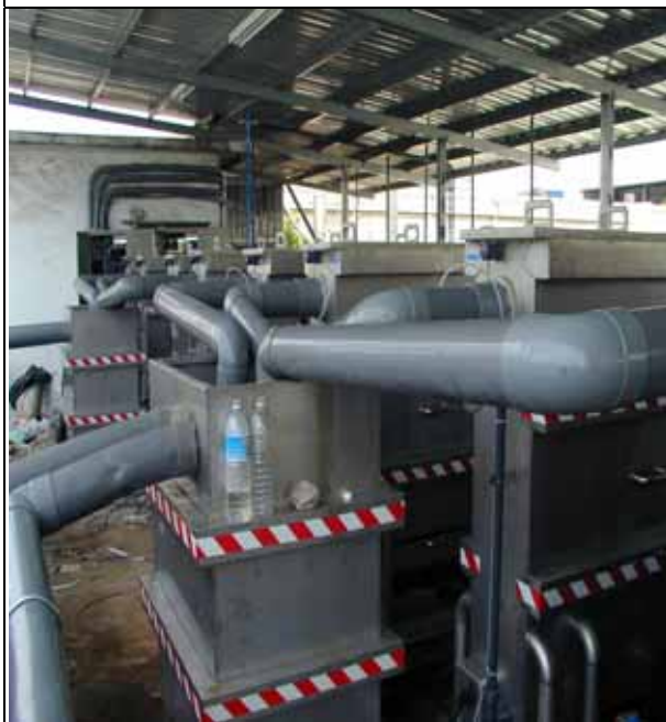
照片 3、設備安裝
