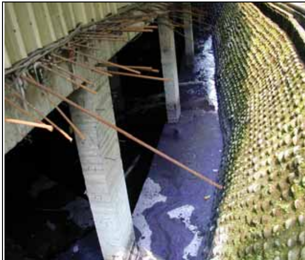
照片一、高濃度廢水地下貯槽
