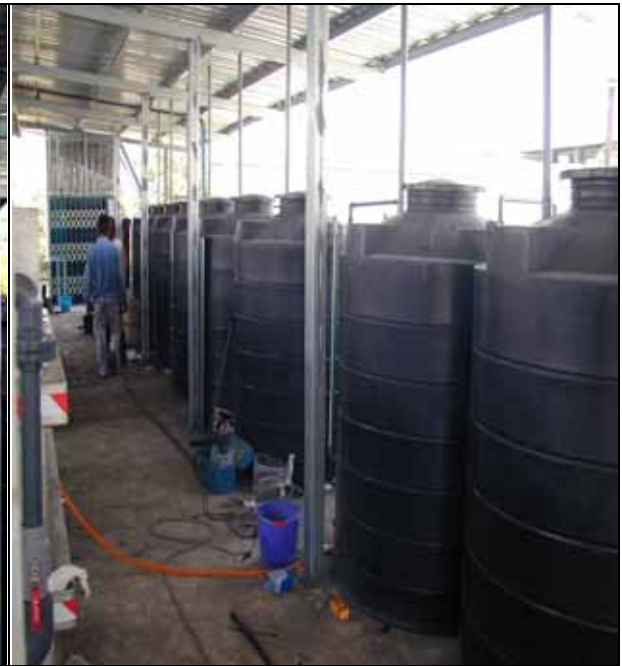
照片 2、設備安裝（藥品儲槽）
