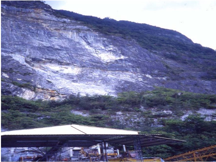
圖 4.2 花蓮崇德地區大理石礦在大雨過後產生落石災害
