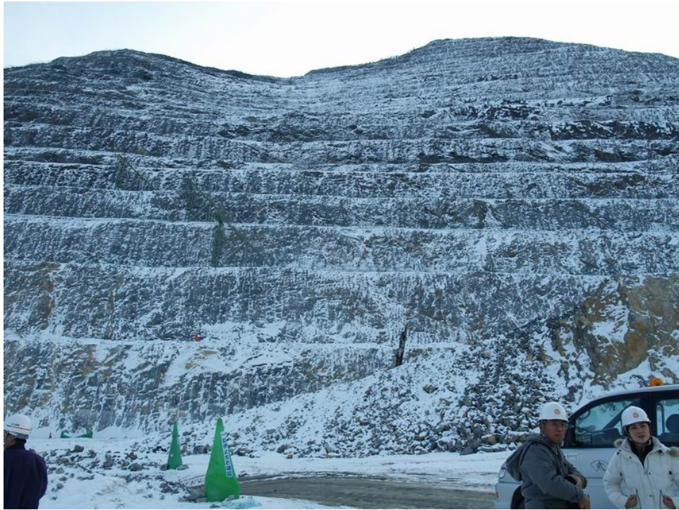
圖七 武甲石灰石地區三家礦業公司均使用階段式向下開挖
