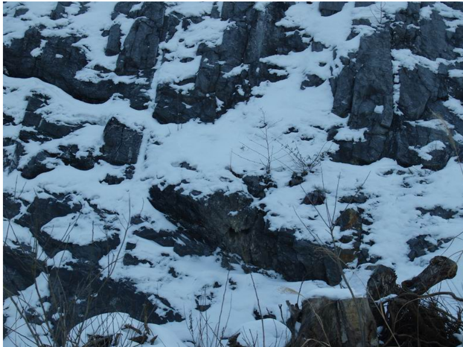
圖九 武甲礦山的石灰岩已經有受變質作用，呈現微隱晶質構造，色澤烏黑，岩層非常破碎
