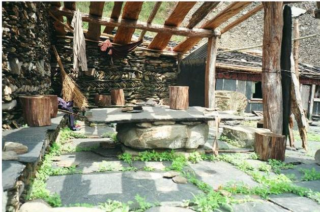
圖 2-2-94 射鹿聚落石板屋風災後現況，休憩涼亭屋頂被掀起，石板屋主體有漏水發霉現象(頭目李正家屋)(盧惠敏攝影)
