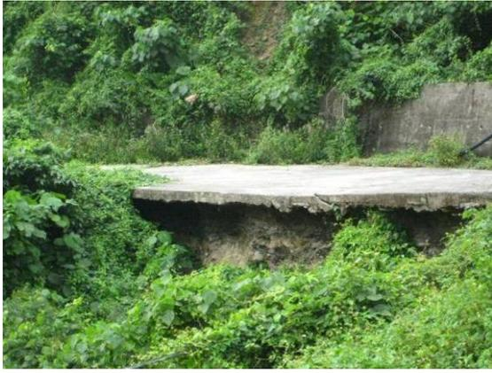
圖 2-2-53 達來吊橋前 50 公尺路面地基洶空
