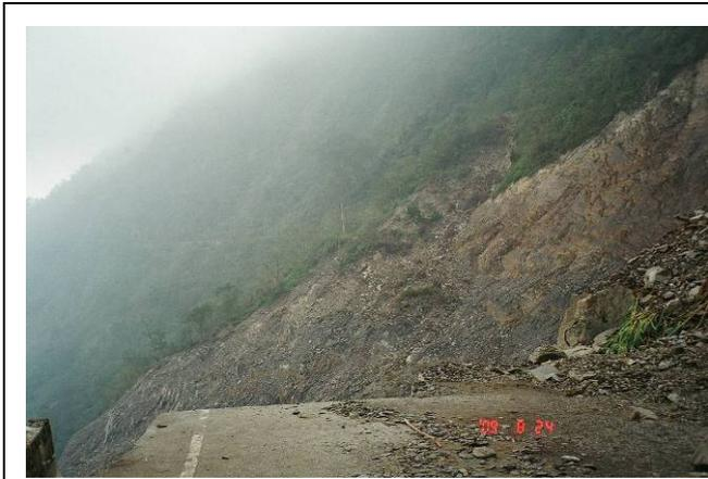
圖 2-2-88 第 1 崩塌處，筏灣道路 15k 處路基嚴重流失 (盧惠敏攝影)
