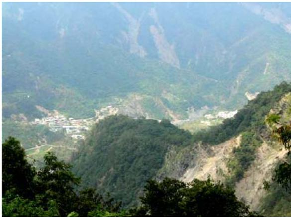
圖 2-2-10 部落前大型崩塌，路基嚴重流失
