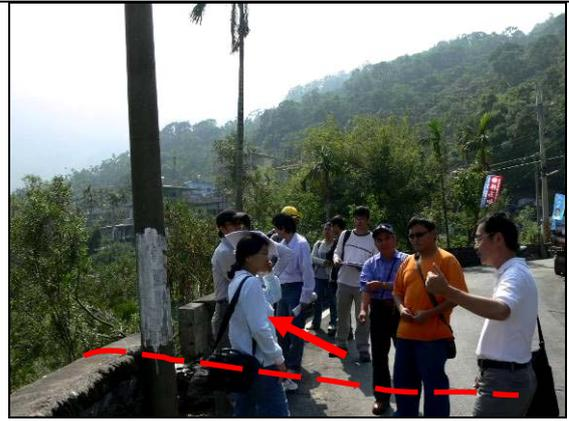
圖 2-2-79 滑動區左側之屏 35 線道路上垂直位移量約 10cm，水平位移約 20 至 25cm。(紅色點線為地滑邊界)(陳天健，2009)
