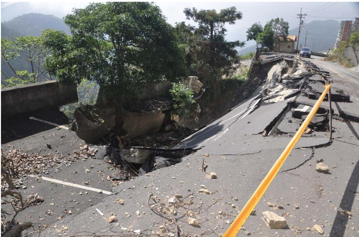
圖2-3-56 藤枝遊樂區停車場地滑嚴重、路面嚴重下陷開裂(盧惠敏攝影)
