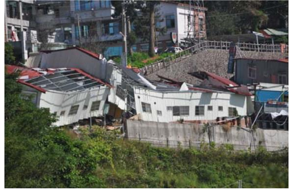
圖2-3-53 藤枝森林遊樂區聚落路基流失，邊坡滑落、商家倒塌(盧惠敏攝影)
