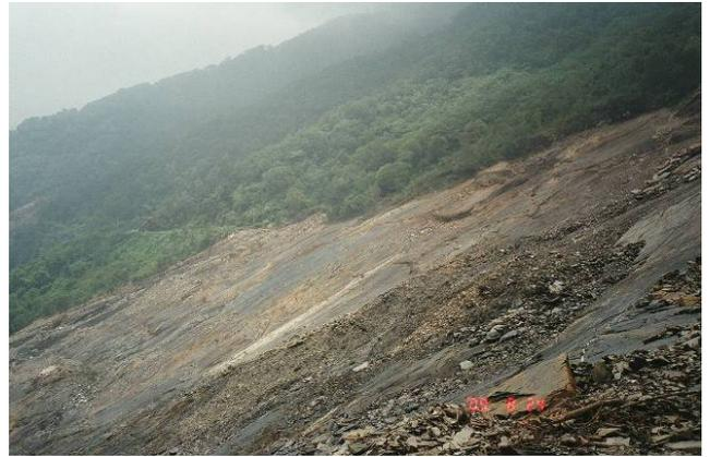
圖 2-2-89 第 3 崩塌處，約長達 200 公尺，路基嚴重流失，崩至順向岩壁才停止 (盧惠敏攝影)
