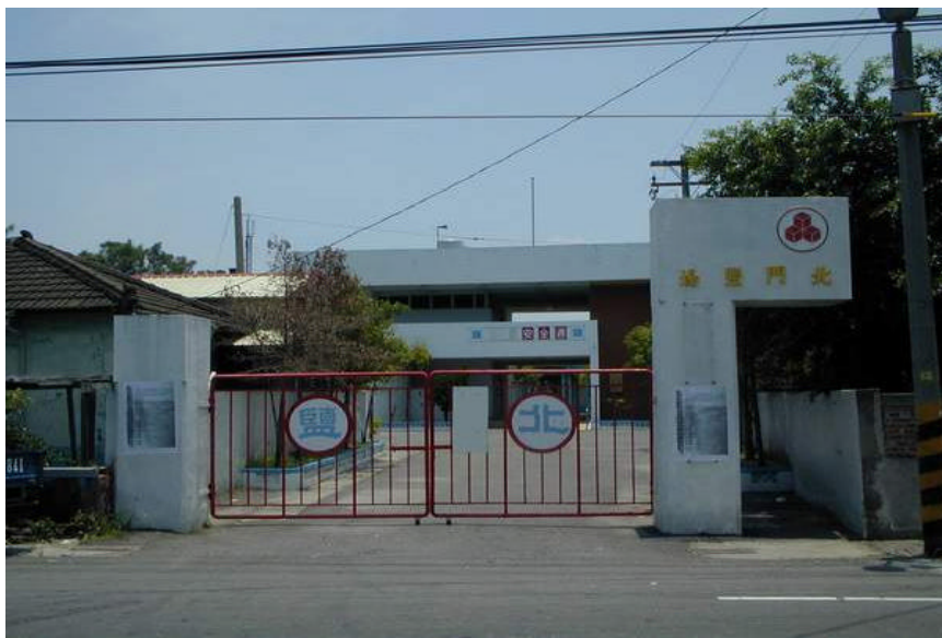
圖 6-4 配合鄉鎮空間再利用計畫之鹽場設施
