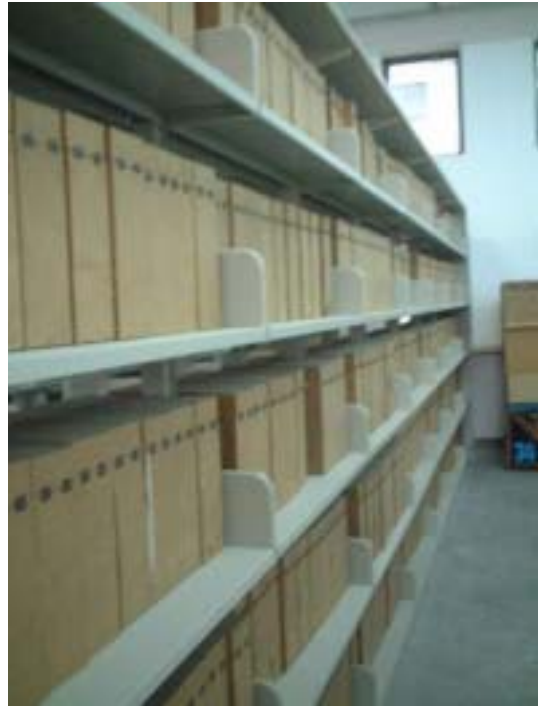
圖(二)5-2-1 北京首都圖書館全館採用活載重設定 1500\text{kg}/\text{m}^2 ，設定為全館皆可使用密集書架
