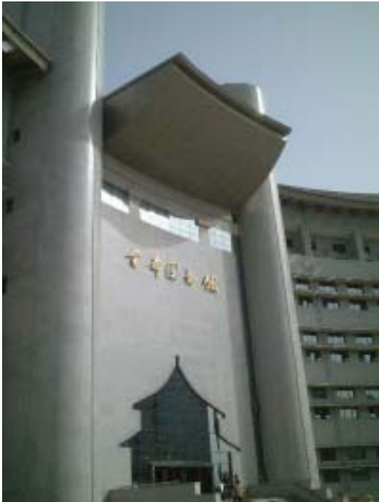
圖(二)5-2-1 北京首都圖書館全館採用活載重設定 1500\text{kg}/\text{m}^2 ，設定為全館皆可使用密集書架
