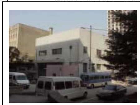
圖(一)3-1-76 空調機房單獨設立於庫房棟外
