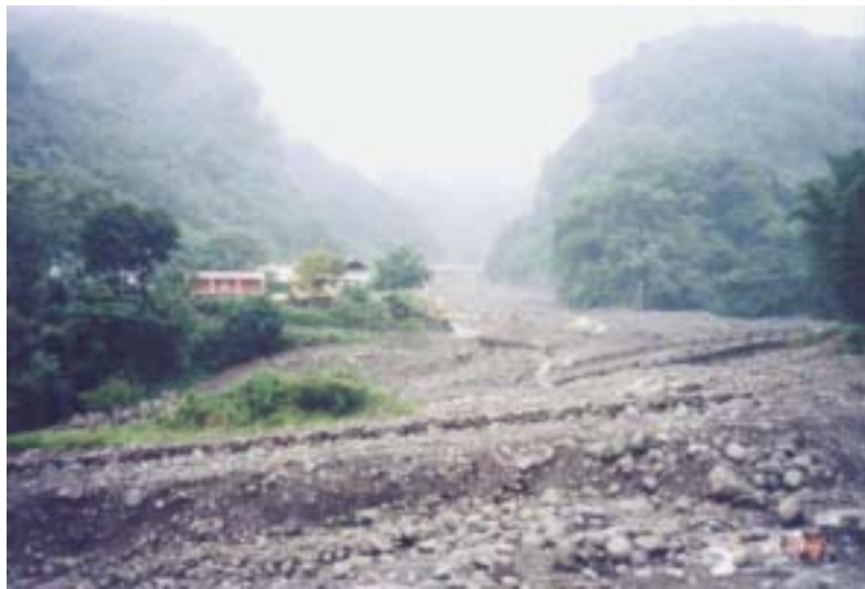
圖 3.5、神木村土石流災變
