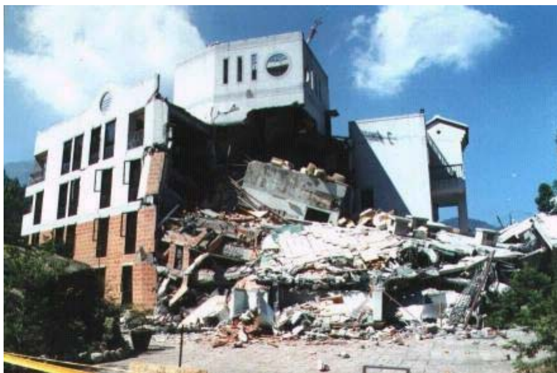
圖 2-13 溪頭森林遊樂區私人經營之旅館被震倒塌
