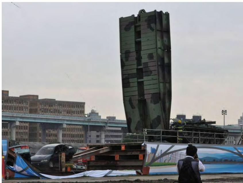
照片 6 國軍道路搶修架設機動履帶倍力橋
