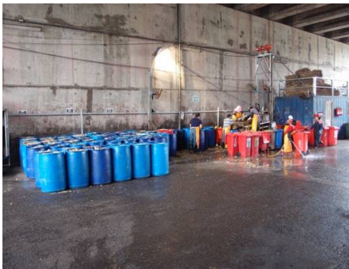
附圖 4-2 土城區廚餘堆肥場
