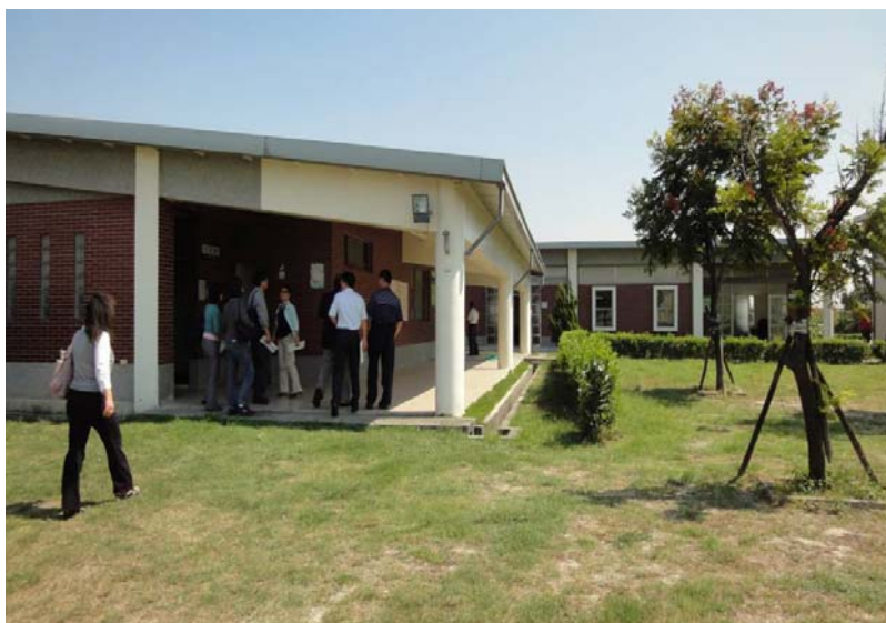
附圖 4-4 秀水鄉家具修繕場
