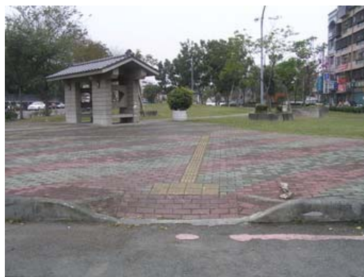
圖 6.1.2 民生公園綠帶出入口坡度較大，且中央行走空間較窄
