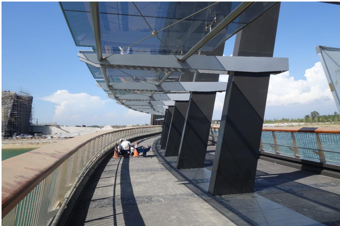
照片 2：景觀橋工程驗收現況
