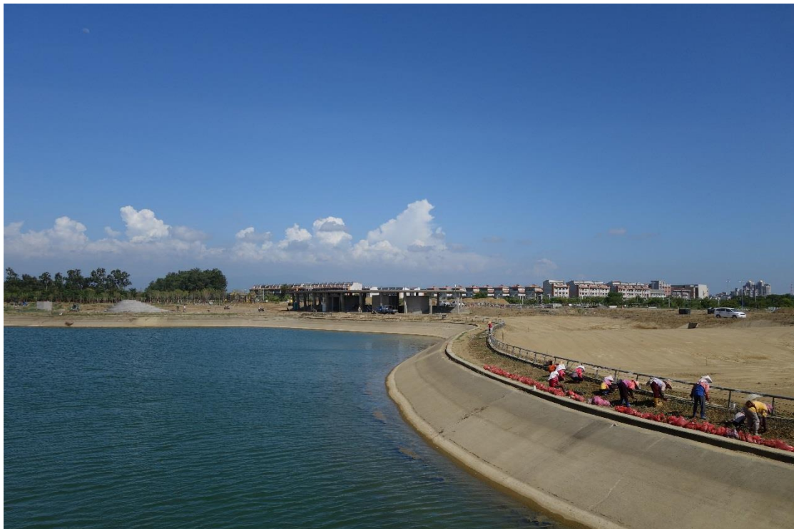
照片 14：園區景觀工程-臨湖綠堤區域工人從事植栽工作現況
