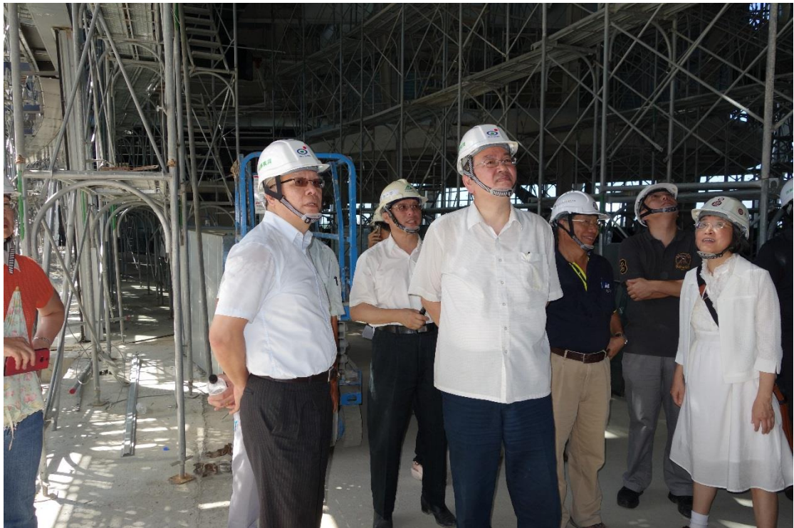
照片 3：實地查證博物館主體建築內部施工現況
