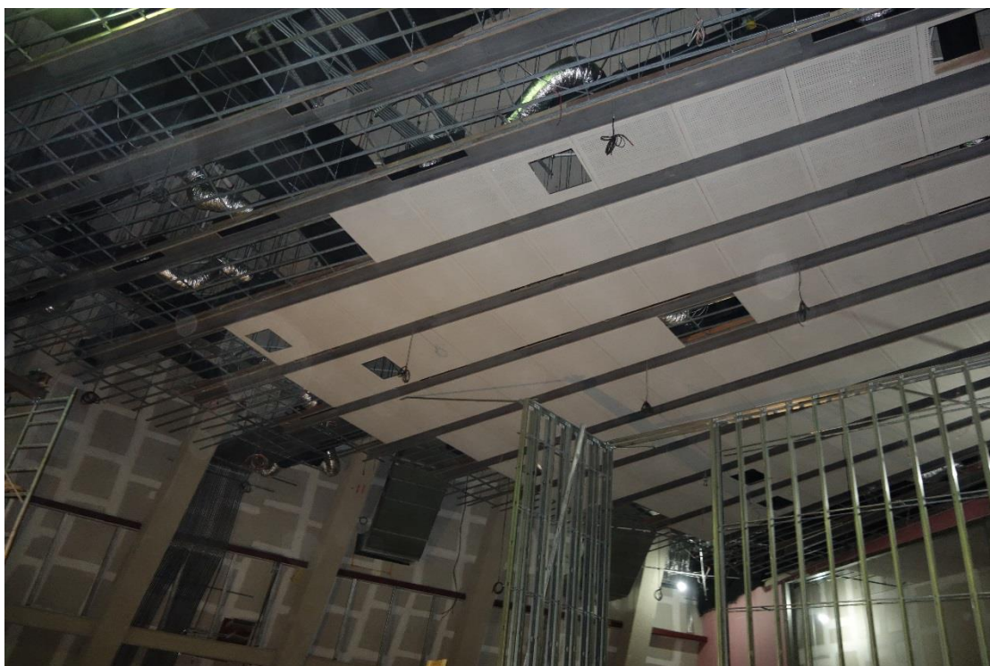
照片 7：博物館主體建築庫房內部天花板施工現況
