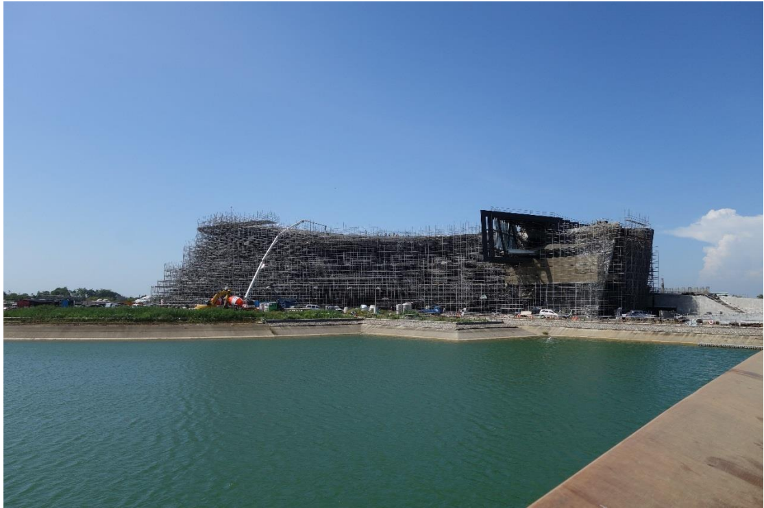
照片 11：從景觀橋遠眺博物館主體建築施工現況
