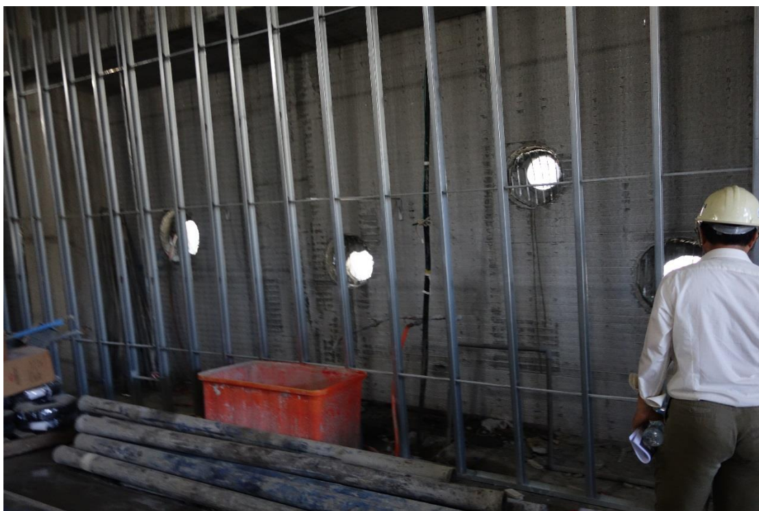
照片 5：博物館主體建築內部牆面施工現況
