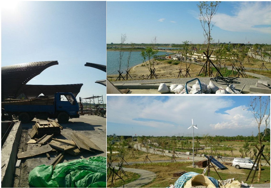
照片 13：園區景觀工程-臨湖綠堤區域圓形廣場及藝術之丘施工現況
