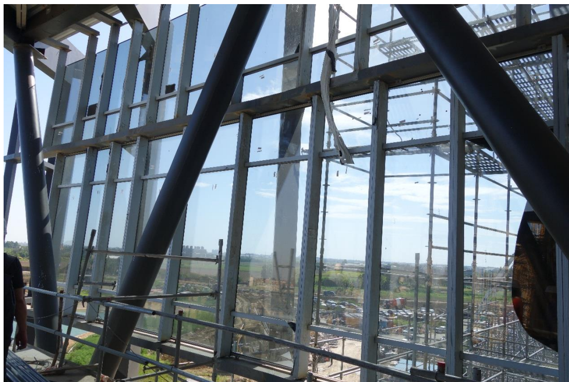
照片 6：博物館主體建築帷幕牆玻璃安裝現況
