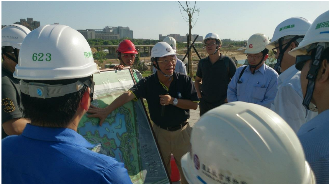
照片 12：實地查證園區景觀工程施工現況
