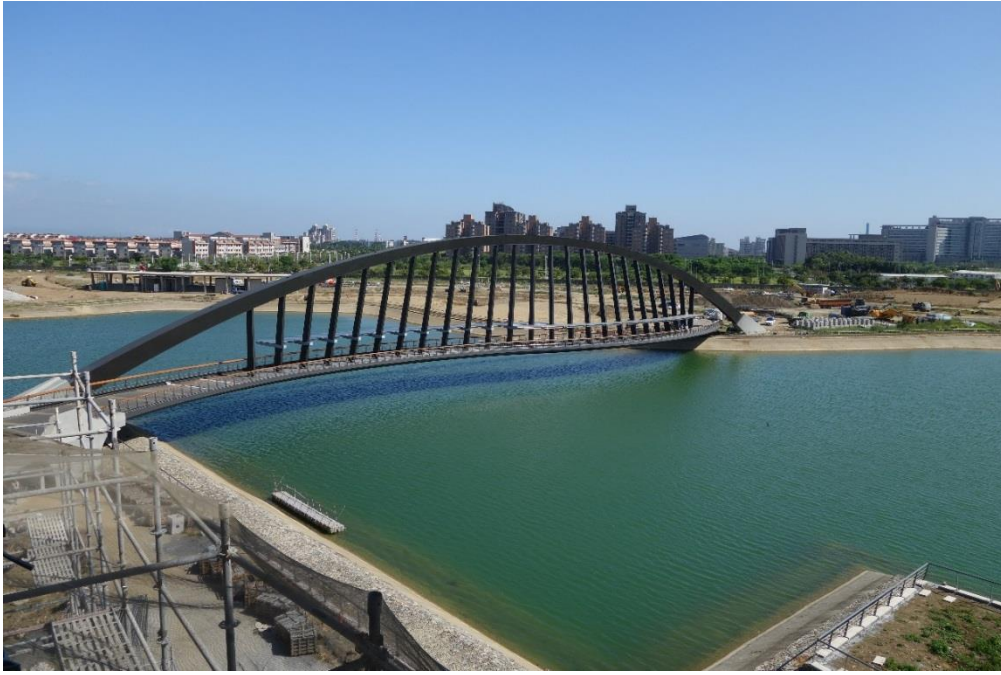
圖 6 景觀橋完工現況
