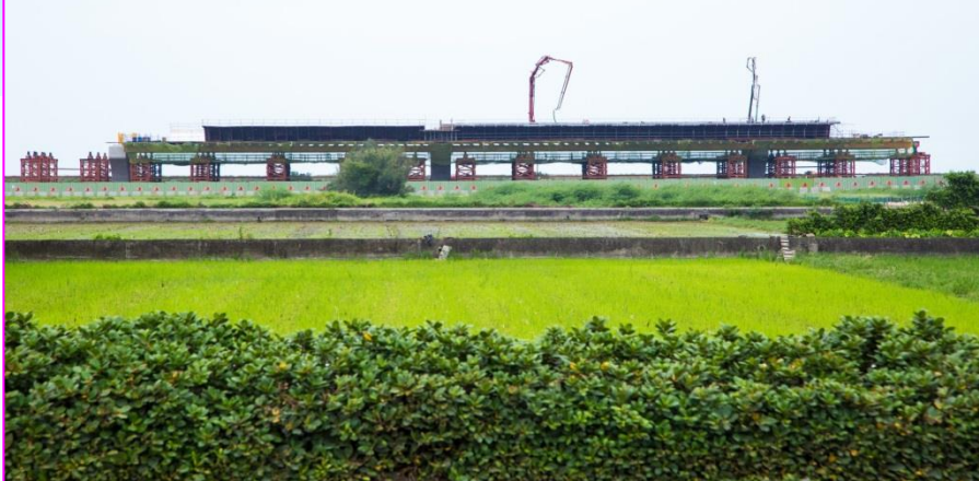
箱型梁施工情形
